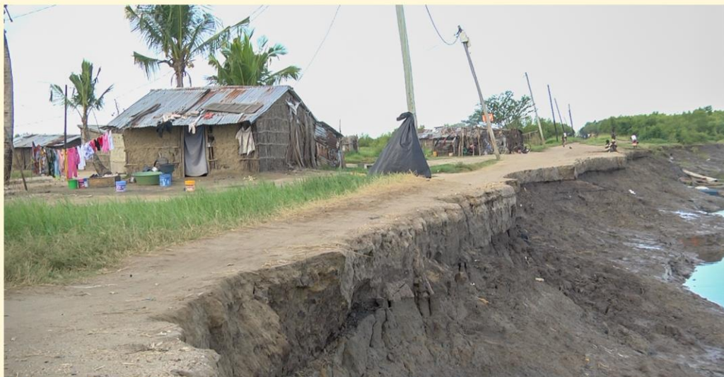
©Hoje em Moçambique: Casas em perigo no bairro de Icidua
