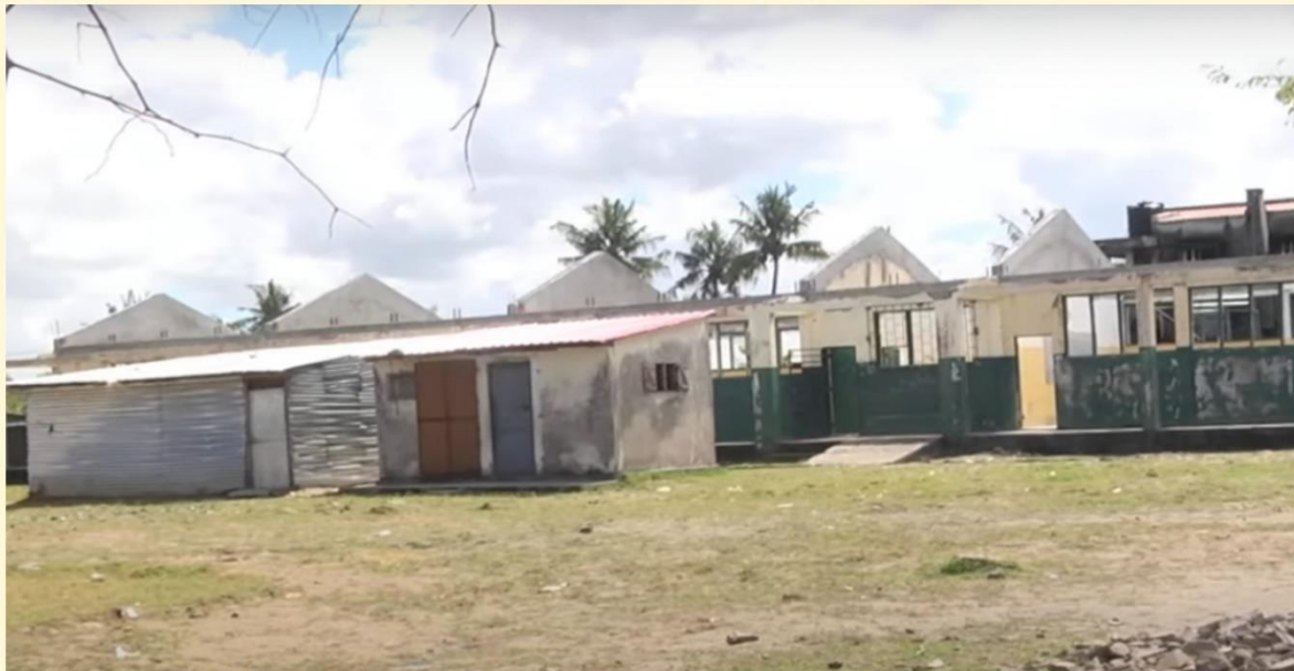
©Hoje em Moçambique: Obras paralisadas
