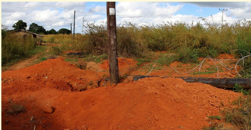
@Hoje em Moçambique: Obras de instalação da nova ligação da corrente eléctrica, bairro Sete de Abril distrito de Ximbunila
