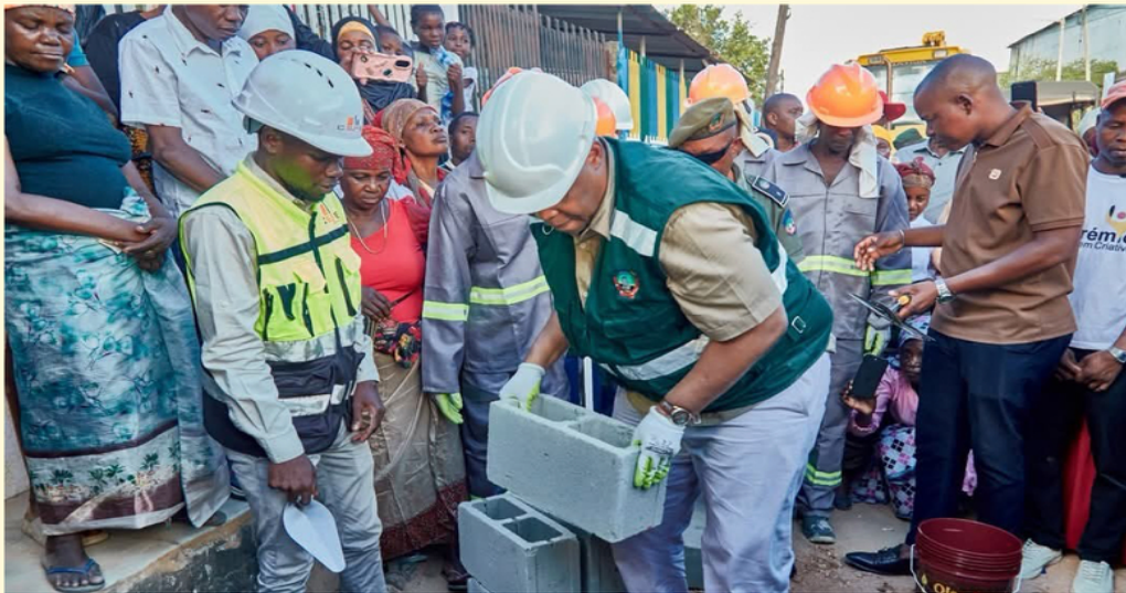
Hoje em Moçambique: momento de lançamento da primeira pedra da nova estrada.
